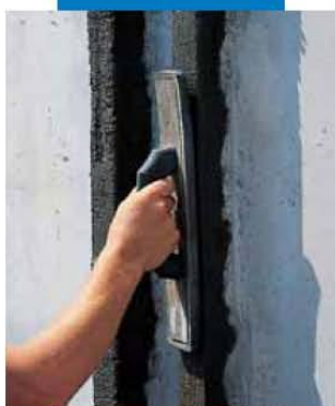
Rifinitura con frattazzino
