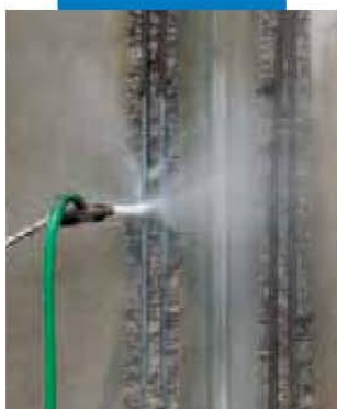
Pulizia dei ferri con idrosabbatura
