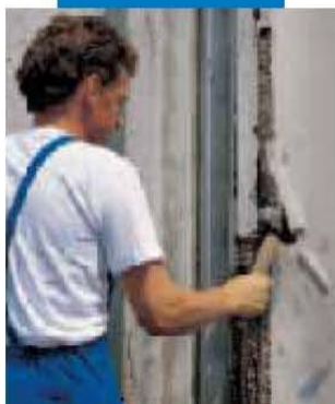
Demolizione del calcestruzzo degradato
